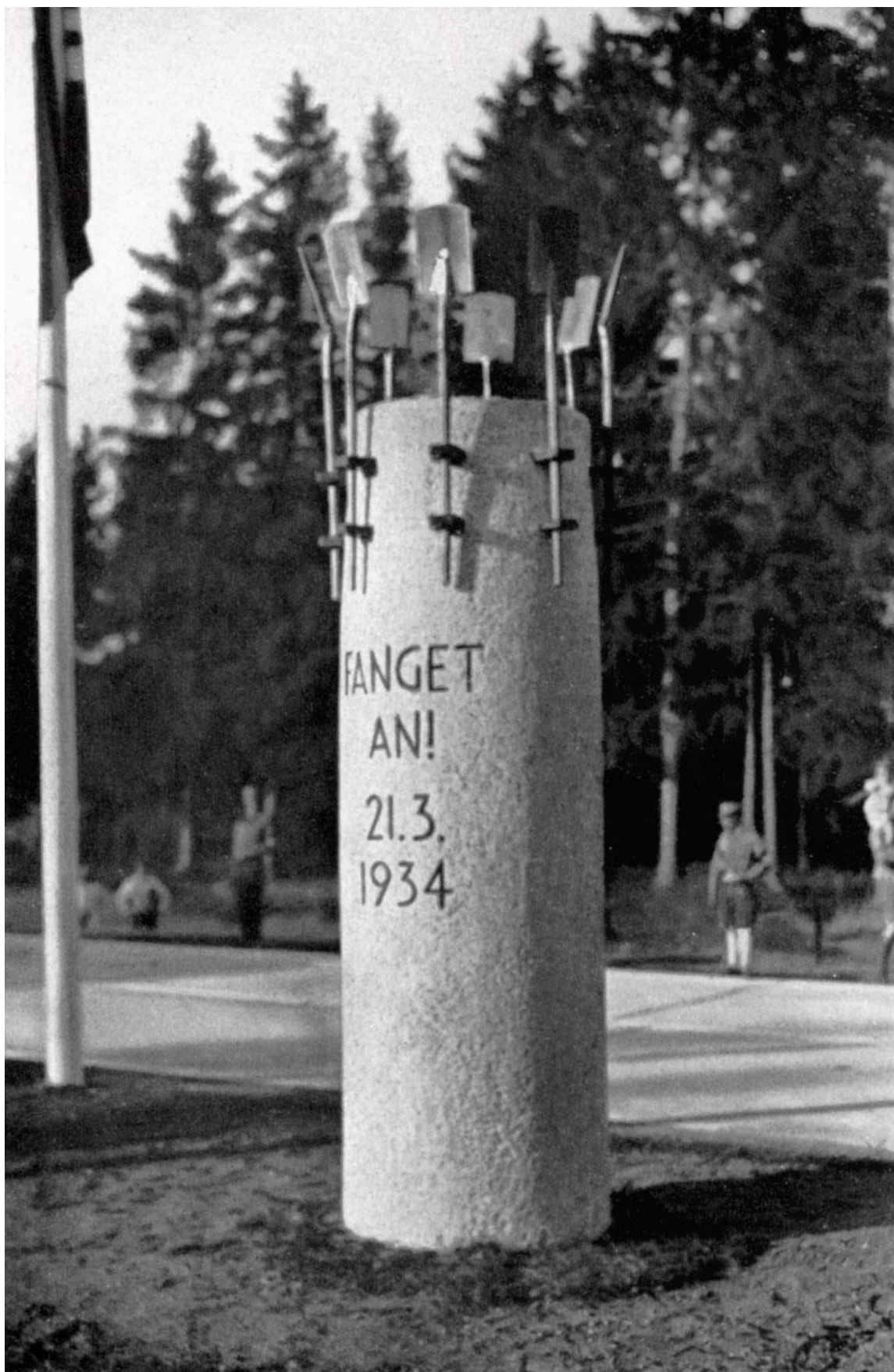
Колоната означава началото на строежа на аутобана Мюнхен – Ландесгренце. Надписът гласи – „Да се захващаме! 21.3.1934 г.“
